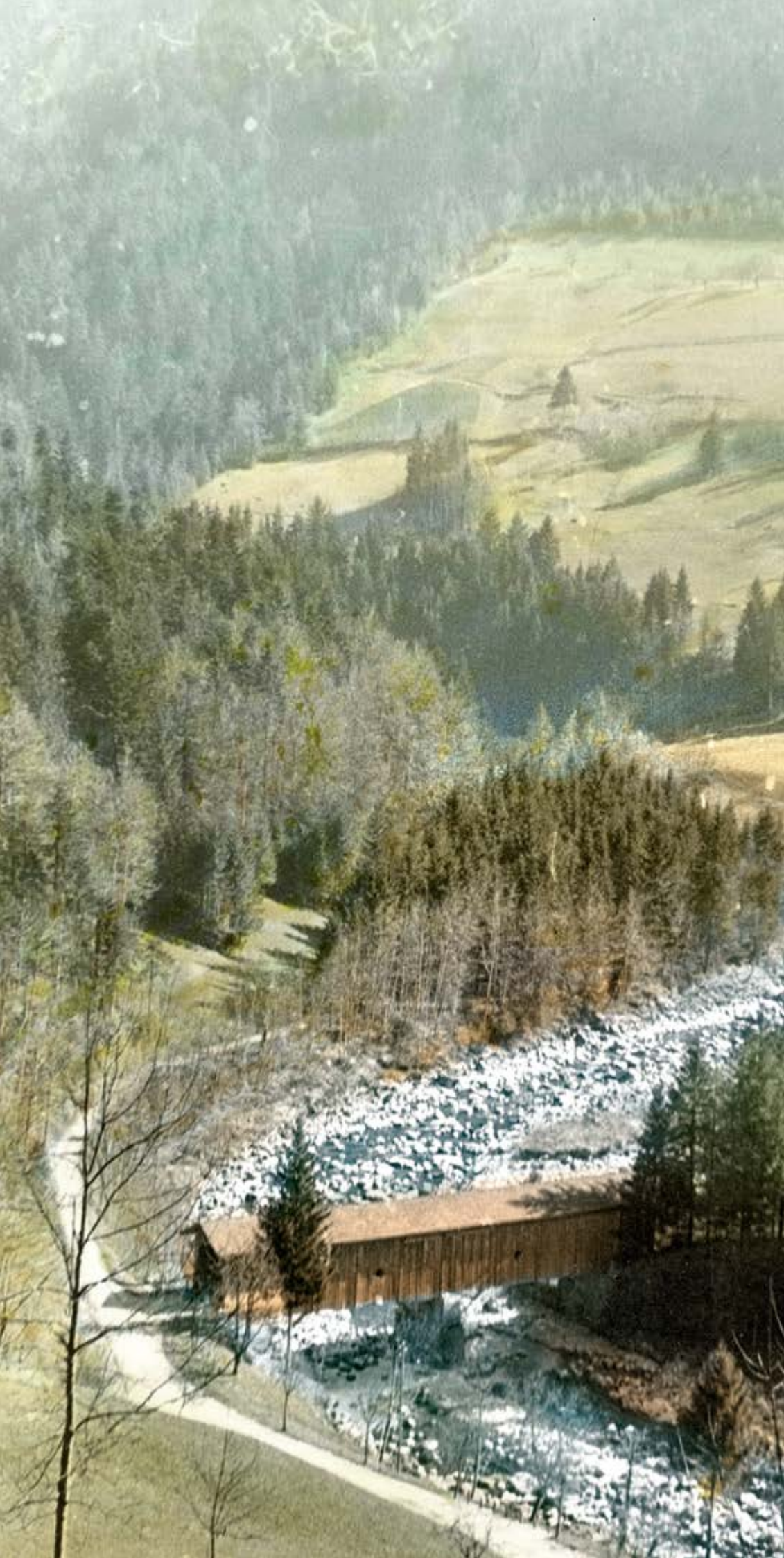
Die ehemalige Holzbrücke bei Finstersee, 1945. ETH Bildarchiv.
