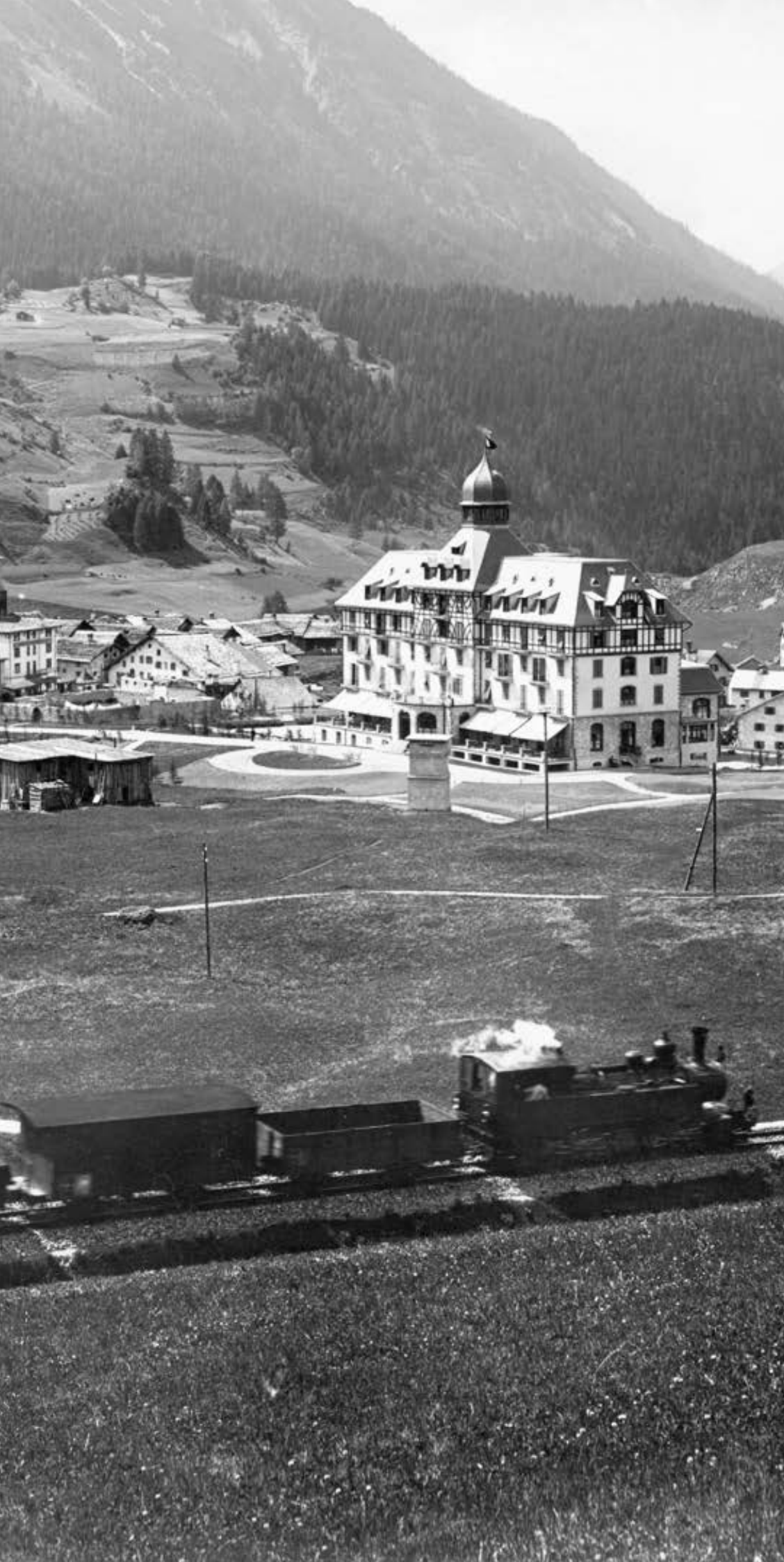
Das Kurhaus Bergtün mit der Albulabahn im Vordergrund, um 1910. Archiv Kurhaus Bergtün.
