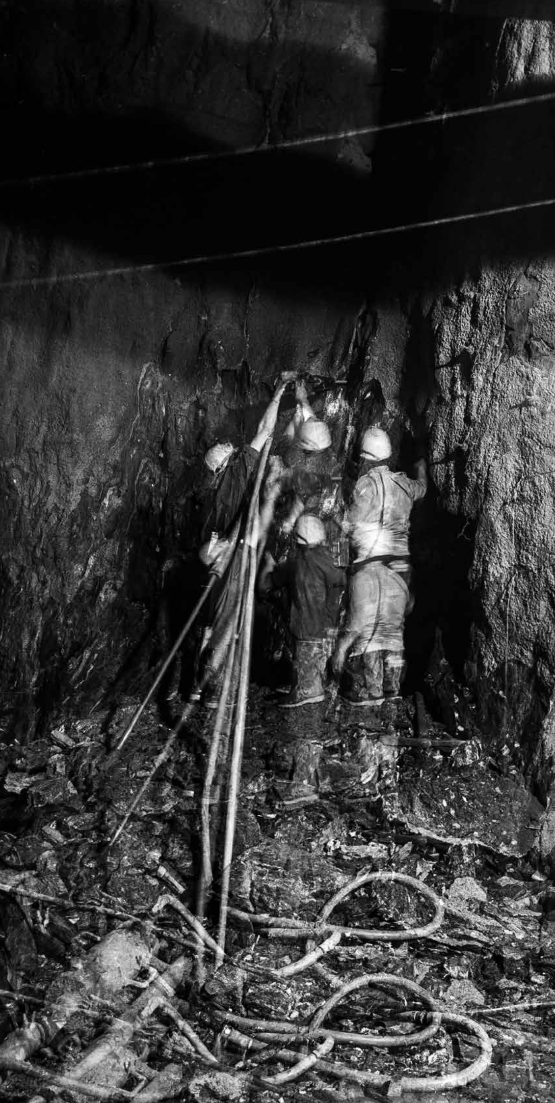
Tunnelarbeiter im Vortrieb. © Walter Scheidegger, Ambri.
